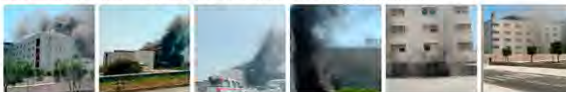
Figura 2. Immagini dell'ala dell'Ospedale Generale Regionale "F. Miulli" interessata dall'incendio occorso alle ore 10 circa di martedì 11 luglio 2023.
